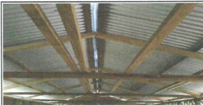
Foto 5: Se ha observado que la estructura del techo está construida con material de madera, lo que representa un riesgo para la estabilidad del establecimiento en el desgaste natural de la madera.
